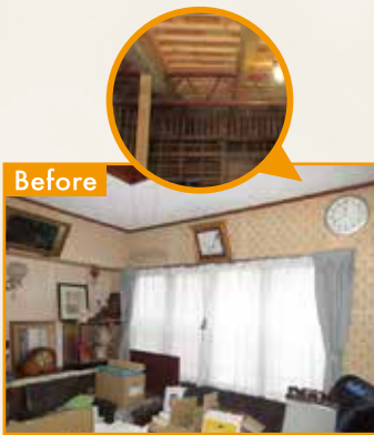
▼以前の応接室の天井裏には、2階の和室を支えるための、構造上外せないトラス（三角形の組み合わせ）の梁がありました
