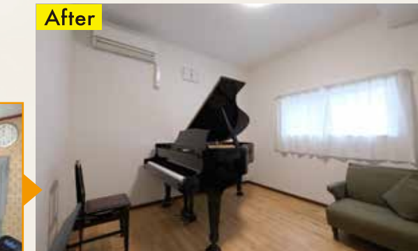
▲ピアノ室は耐荷重を上げるために床を補強。天井も、梁がある箇所以外は高さを上げたため、ピアノの大屋根を開けても圧迫感がありません
