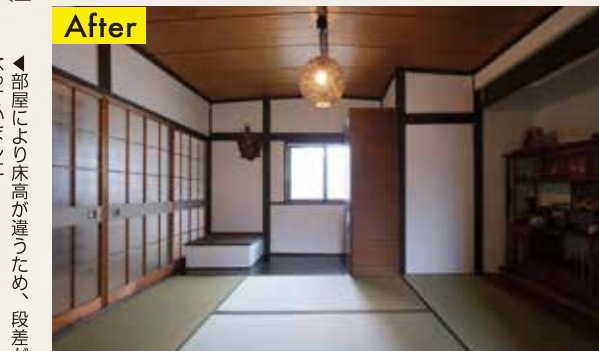
▲階段の天井高を上げるため、1畳半ほどを板張りに変えて、和室の床の一部を高くしました
