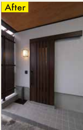
▲玄関横には道路側に目隠しフェンスと立水栓を設置。フェンスの台座までタイルを貼ってスッキリとした見た目に
