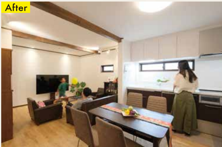
▲玄関とホールだった部分を取り込んでスペースを広げたLDK。柱を抜く代わりに追加した補強の梁と並ぶ飾り梁が空間のアクセントになっています
