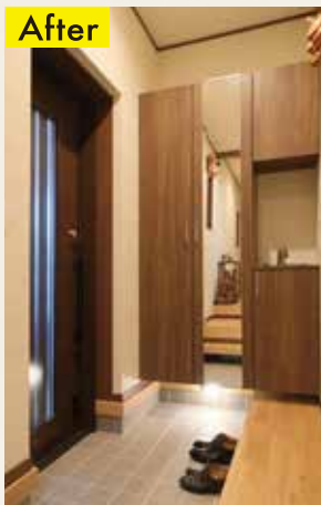
▲玄関収納までつながる式台は、無垢材で造作。収納下にコンセントを付け簡易な間接照明をセット
