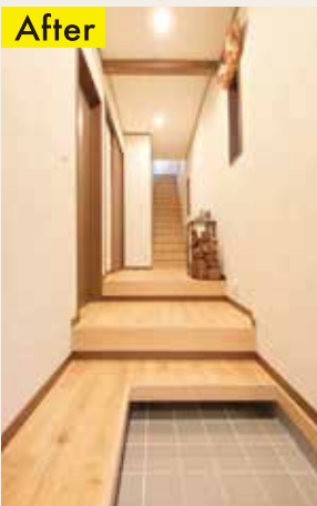
▲玄関から階段までの床の高低差を埋める段差は、均等な間隔にして見た目も整然と
