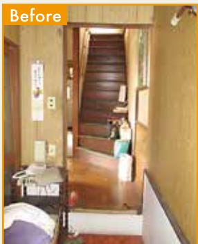
◀部屋により床高が違ったため、段差が多くなっていました
